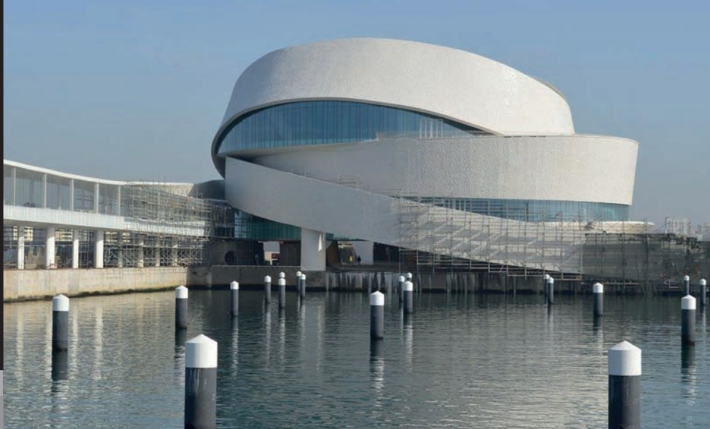
Novo Terminal de Cruzeiros do Porto de Leixões
