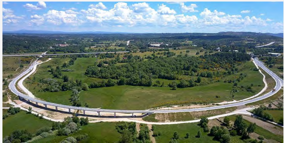
Modernização da Linha Ferroviária da Beira Baixa e ligação à Linha da Beira Alta. Esta obra também permite a ligação direta entre duas importantes cidades do interior, Guarda e Covilhã. O troço, que se estende por 46 Km e inclui várias obras de arte, teve a intervenção de 6 empresas associadas
